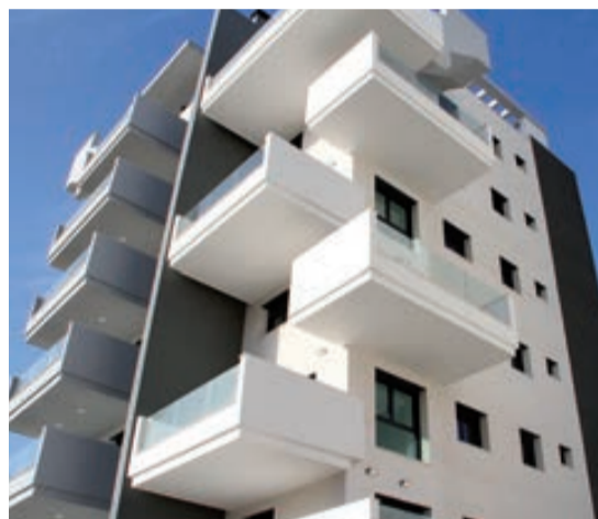
Añil finalizó en 2022 las 44 viviendas Urban Litoral, el primer edificio con certificación Passivhaus de Andalucía. Foto superior, detalle del edificio y a la derecha, vista de las viviendas.
